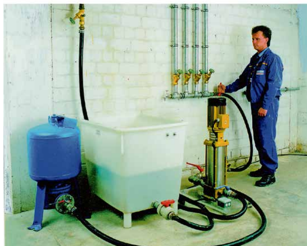
Das Spülverfahren von Bohres macht einen Austausch der gesamten Wasserrohre überflüssig.
